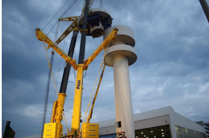
Abheben des obersten Turmsegments
